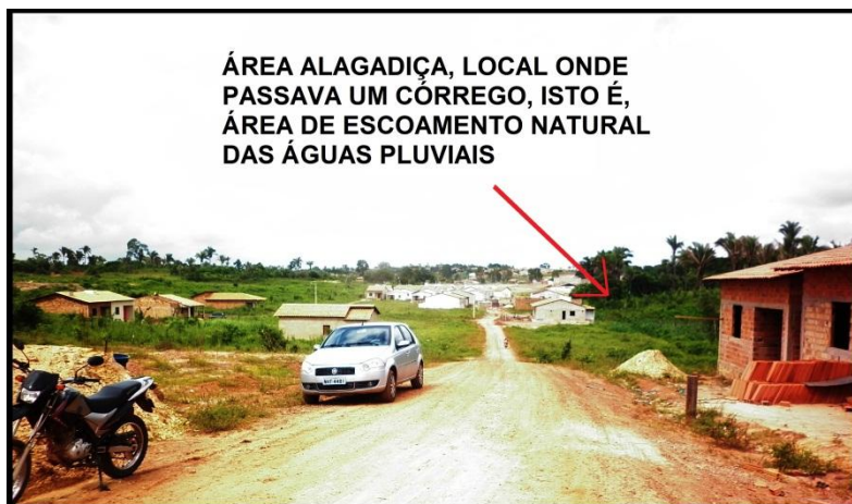
Figura 02: bairro construído em área de escoamento pluvial
