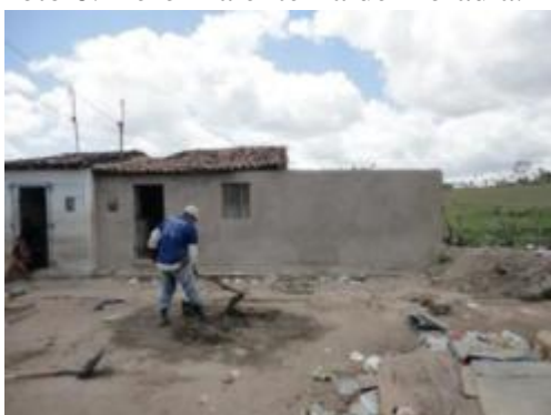
Foto 6: Reforma externa de moradia.
