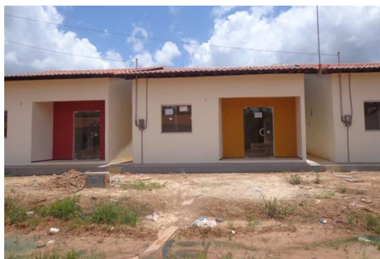
Figura 03: Loteamento privado em fase inicial de implantação.
