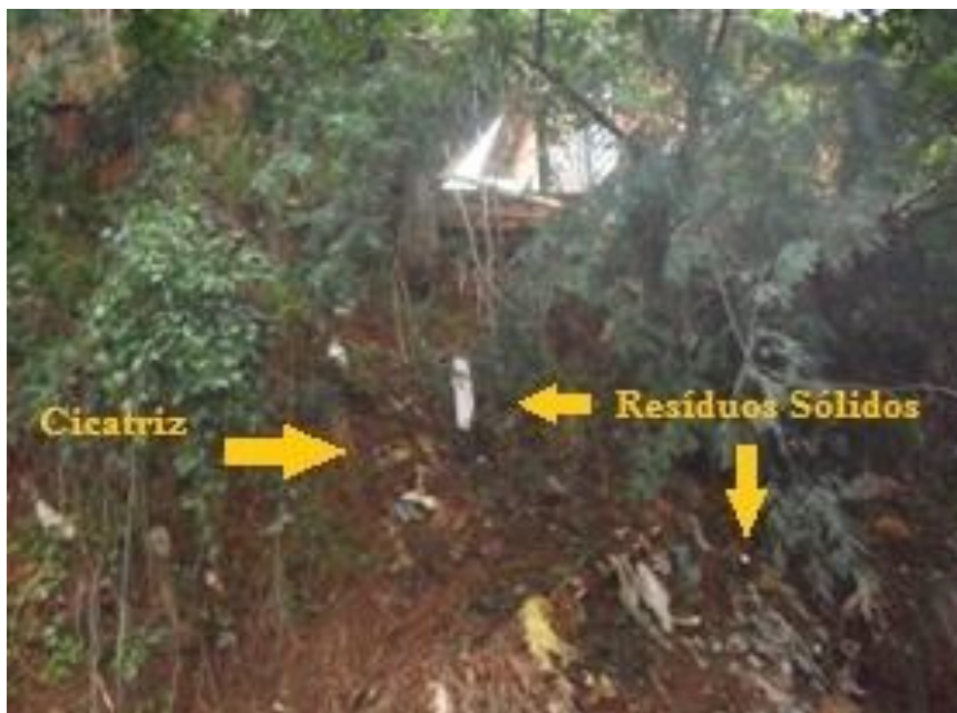
Figura 3 - Casa sobre depósito de colúvio, cicatriz de escorregamento e resíduos sólidos.
