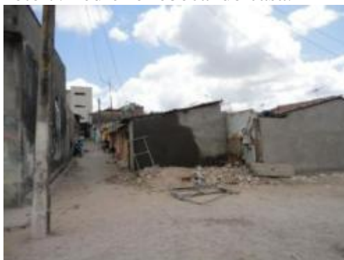
Foto 7: Pedreiro rebocando casa.
